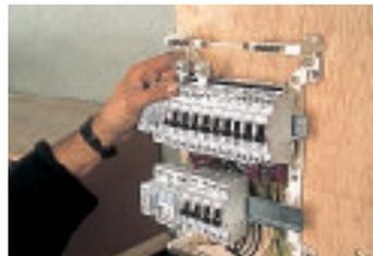
18. Insérer, dans une borne neutre et dans une borne de phase, des bornes d'arrivée.
