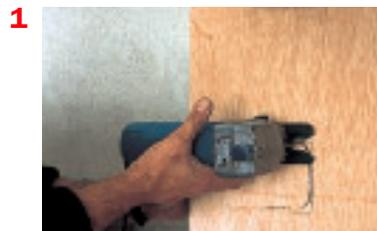
**1. Découper une fenêtre dans le panneau support pour le passage des fils.**
